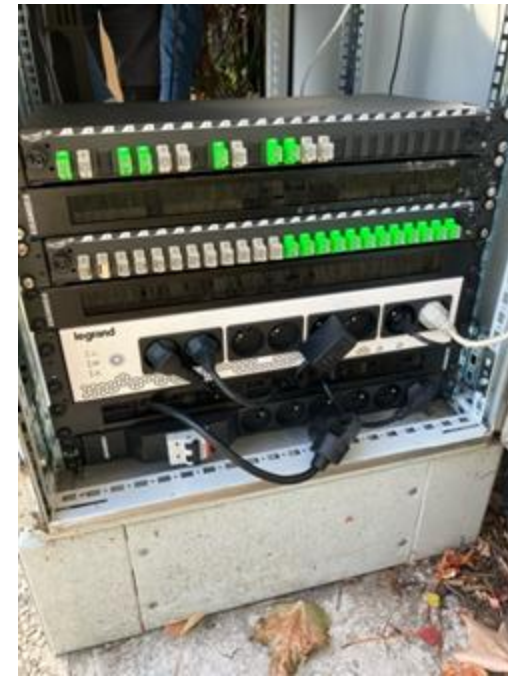
Installation multifibre pour instrumentation poutre béton - EDF
