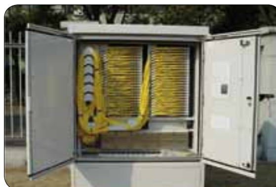
Figure 4.70 : armoire câblée à 100%
