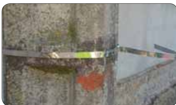
Figure 6.8 : mise en place du cerclage feuillard
