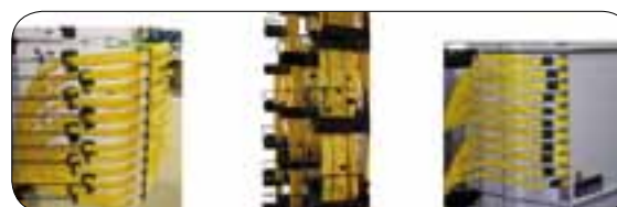
Figure 4.66 : câblage d'un répartiteur à 100% de jarretières
