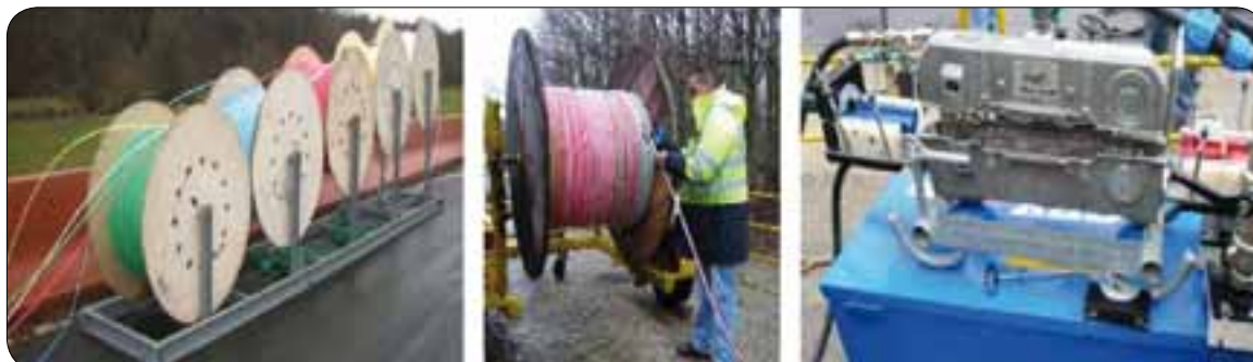
Figures 5.16 pose de micro-tubes indépendants et micro-conduite
