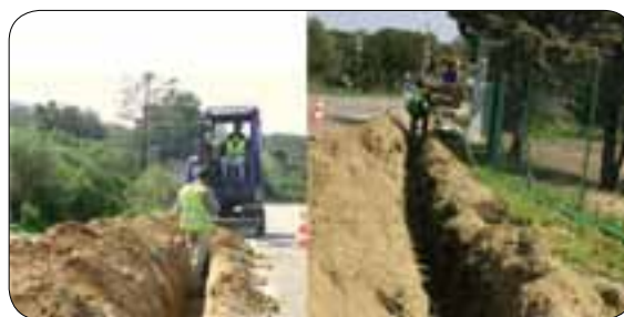
Figure 5.2 : pose de fourreau en tranchée standard
