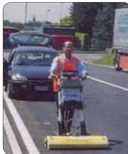
Figure 5.5 : étapes de mise en œuvre de micro-tranchage - détection des réseaux existants sous chaussée
