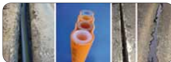
Figures 4.4 : assemblage de micro-tubes en nappe et pose en rainure
