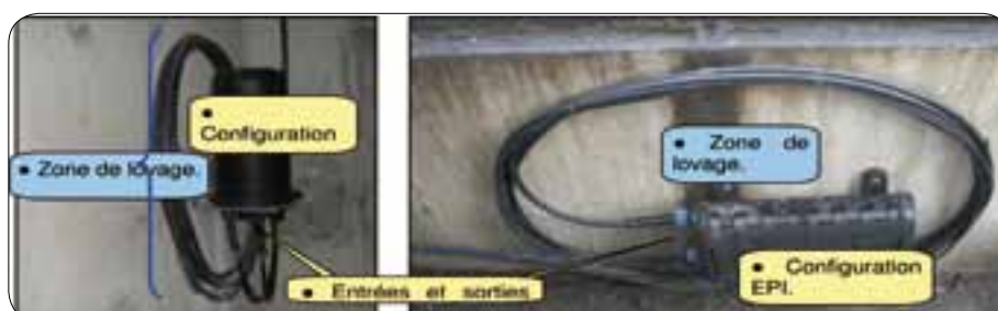
Figure 6.11 : Positionnement d'un joint dans une chambre
