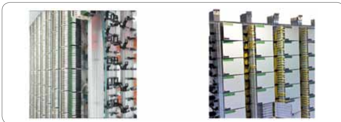
Figure 4.62 : répartiteurs sur fermes
