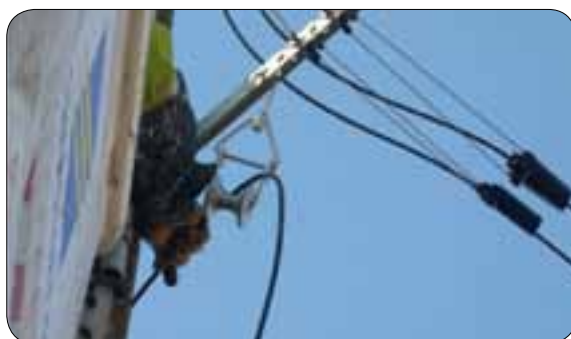
Figure 6.5 : mise en place des poulies provisoires
