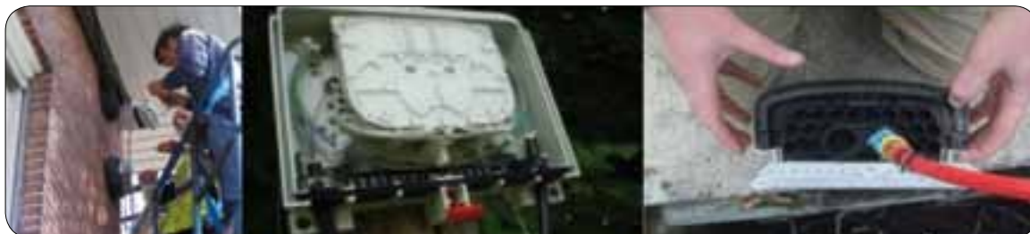
Figures 4.80 : points de branchement optique façade, poteau et souterrain
