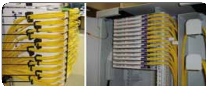
Figure 4.45 : illustration de l'installation d'un pigtail 2mm
