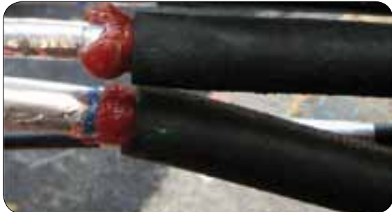
Figure 6.13 : entrée de câble par thermo rétractable
