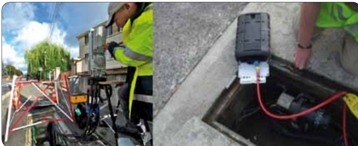
Figures 6.12 : installation d'un boîtier dans une chambre
