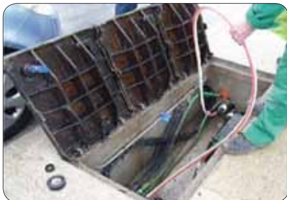
Figures 5.15 : pose de micro-conduite
