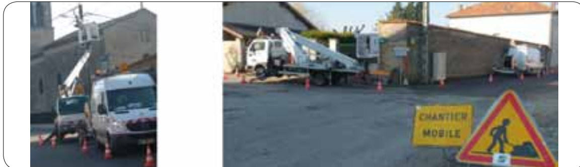
Figures 6.4 : mise en place du balisage
