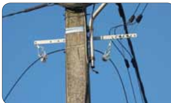
Figure 6.6 : passage dans les poulies
