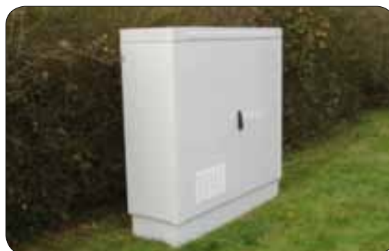
Figure 4.67 : armoire de rue RAL 7035 anti graffiti
