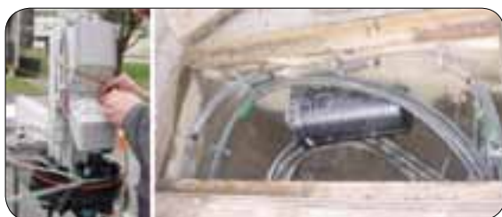
Figure 4.75 : boîtier de jonction et piquage
