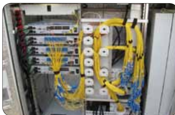
Figures 7.4 : exemple de NRO AON (réseau départemental de l'Ain mis en place par le SIEA) et de CPE chez l'abonné (la gestion des fibres est intégrée dans le module abonné)
