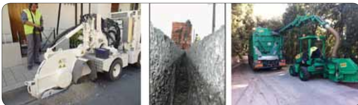
Figures 5.4 : machine de micro-tranchage en milieu urbain
