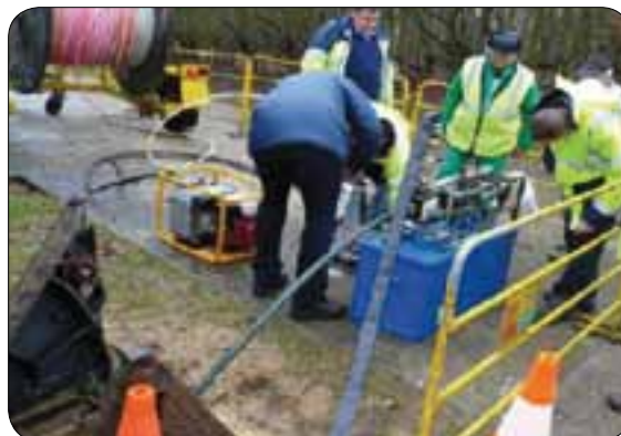
Figures 5.15 : pose de micro-conduite
