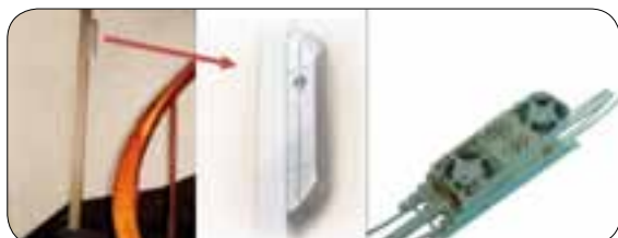
Figures 4.83 : exemple d'un PBO pour le câblage d'un immeuble ancien
