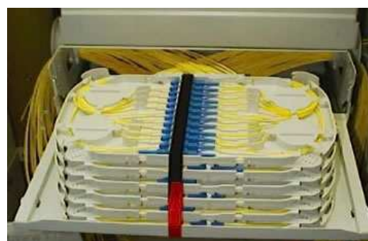
Figure 5.22 : répartitionneur avec modules pré-câblés et jarretières 2 mm
