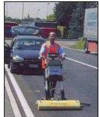
Figure 4.15 : étapes de mise en œuvre de micro-tranchage - détection des réseaux existants sous chaussée
