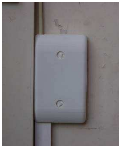
Figure 5.49 : coffret de point de raccordement de palier
