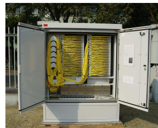
Figure 5.45 : armoire de rue de 576 connecteurs câblée à 100%.
