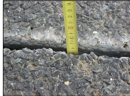
Figure 4.21 : vue d'une micro tranchée
