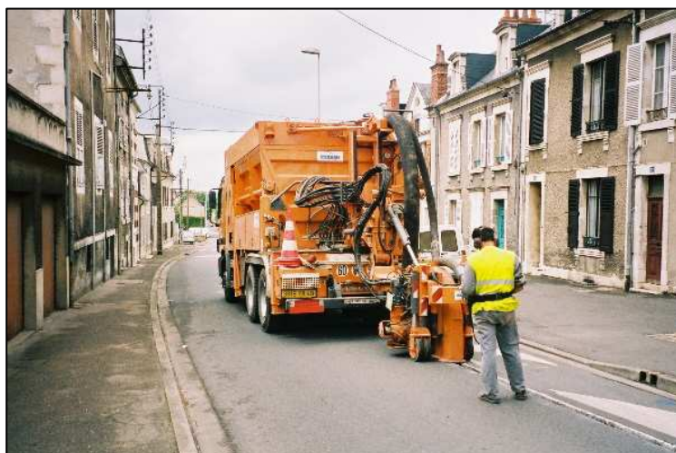
Figure 4.13 : machine de micro-tranchage en milieu urbain
