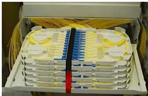
Figure 5.32 : tiroir et ferme de répartition modulaire, chaque module 12 connecteurs étant indépendant des autres.
