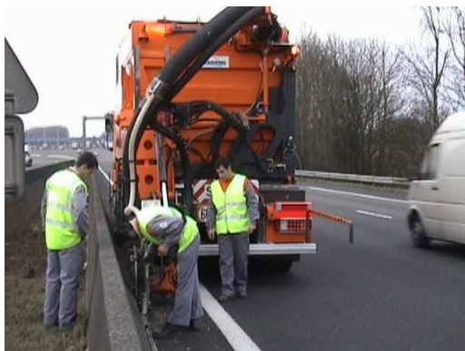
Figure 4.22 : schéma technique et vue de la machine de micro-tranchage pour voies express, roclades, autoroutes
