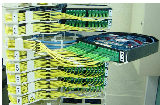
Figure 5.22 : répartitionneur avec modules pré-câblés et jarretières 2 mm
